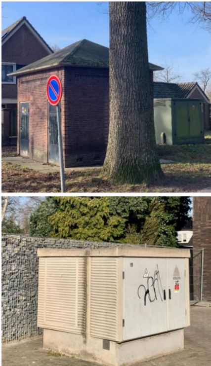
Voorbeelden van MS/LS stations in Helvoirt
