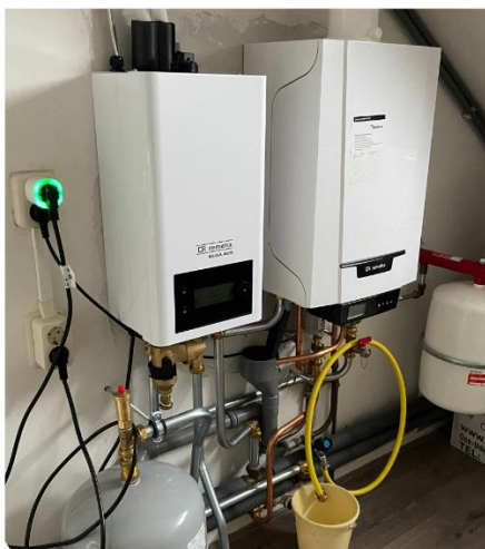
Hybride warmtepomp naast een cv-ketel
