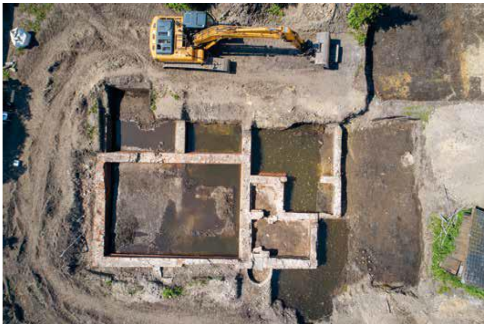
Afb. 4.10 Dronefoto van het funderingswerk van kasteel Spreeuwenburg, ontdekt in 2014 en opgegraven in 2018 (bron: Van den Brink 2020).
