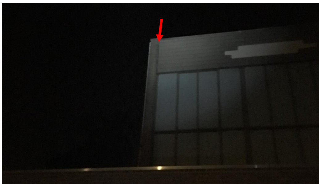
Figuur 5 De zuidgevel vanaf de Lidwinastraat te Vught. De winterverblijfplaats bevindt zich achter de opening tussen het metselwerk en de rabatdelen.
