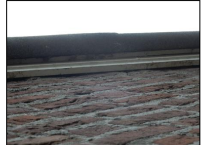
Figuur 15. Ruimte onder betimmering geschikt voor vleermuizen.
