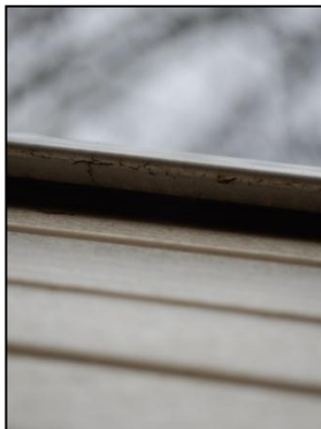
Figuur 16. Ruimte onder daklijst bij bebouwing in gebruik door theatergroep geschikt voor vleermuizen.
