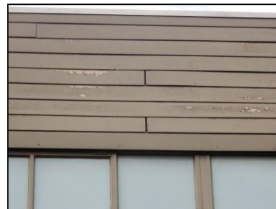
Figuur 17. Ruimte tussen betimmering bij sportschool die geschikt is als toegang voor vleermuizen.
