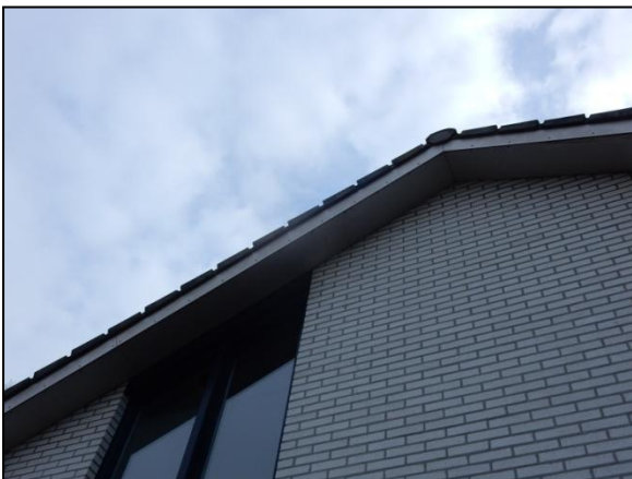
Figuur 9. Geschikte invliegopeningen onder dakpannen voor gierzwaluw bij paramedisch centrum.
