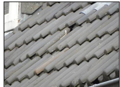
Figuur 18. Ruimte onder dakpannen bij basisschool die geschikte toegang voor vleermuizen verleent.
