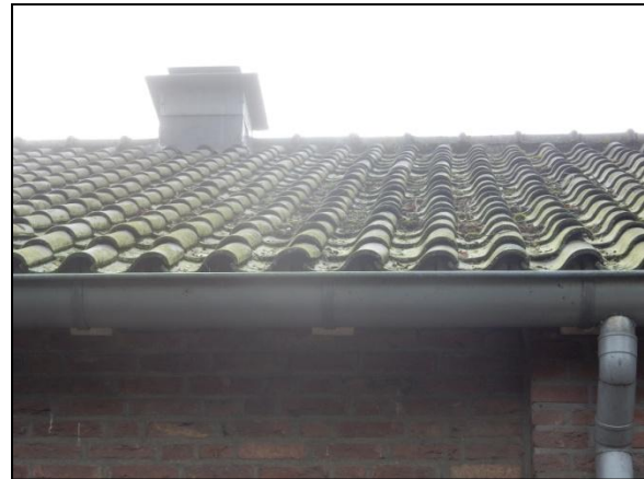
Figuur 12. Dakgoot met toegang tot ruimte onder dakpannen geschikt voor huismus bij kinderopvang.
