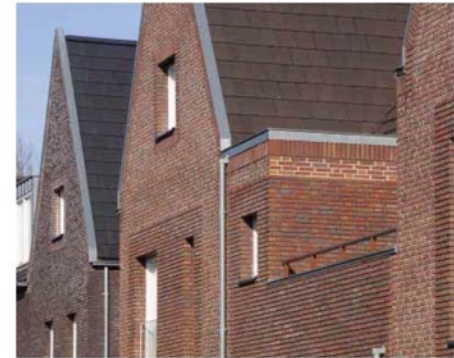
terugliggende voegen zorgen voor dieptewerking
