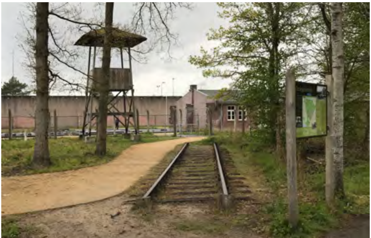
Achterzijde NMKV: herstellen van verdwenen elementen vertelt het verhaal van Voormalig Kamp vught
