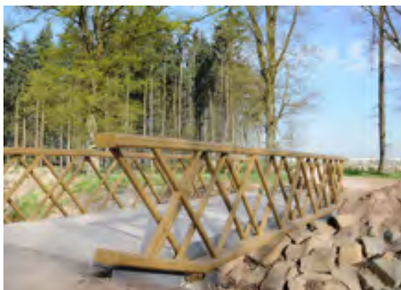
Nieuwe bruggen refereren in vormgeving aan baileybrug
