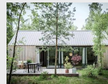
De overgang van privé naar openbaar is zacht, en onderdeel van de architectuur of van de natuur en biedt privacy voor de bewoners.
